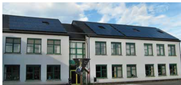
Fotovoltaik Gonnerenger Schoul
