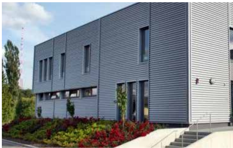
Außenansicht mit Eingang zum neuen Depot
